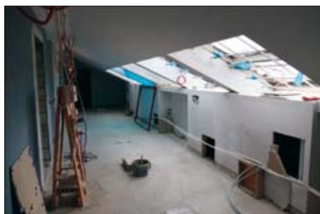
35. Część magazynowa i biurowa MK (poddasze kaponiery) – sierpień 2015 r.
