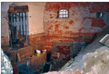
28. Prace budowlano-konserwatorskie w kaponierze w Cytadeli Warszawskiej (przyszłej siedziby biura i m.in. zaplecza magazynowego oraz ekspozycji stałej placówki) – luty 2015 r.
