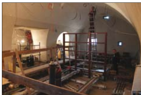
29. Prace budowlano-konserwatorskie w kaponierze w Cytadeli Warszawskiej (przyszłej siedziby biura i m.in. zaplecza magazynowego oraz ekspozycji stałej placówki) – maj 2015 r.
